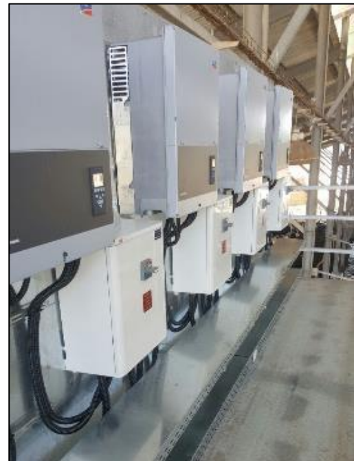
איור 1 ממירים למערכות סולריות, ממירים את הזרם הישיר שמתקבל מהמודולים לזרם עקיף על מנת "לדבר באותה שפה" עם מערכת החשמל הארצית.
